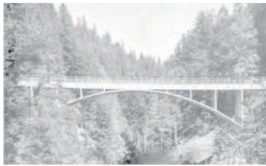
Puente de Schwandbach. Tablero rígido y arco esbelto.
