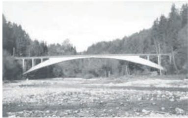
Puente de Aarve. Tablero esbelto y arco rígido.
