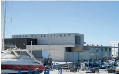
Lonjas en los puertos de Sanlúcar de Barrameda (Cádiz) y Estepona (Málaga).
