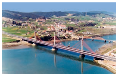
Puente atirantado de Colindres en la Ría del Alsón, Cantabria.
