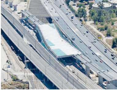
Vigas dobles en una estructura de la autopista norteamericana LBJ y en el viaducto de Santa Catalina.
